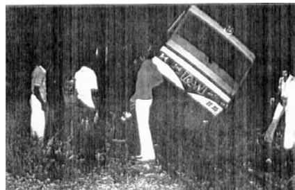
Locomotora del tren descarrilado
